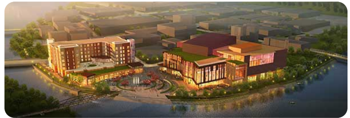
Future Confluence Project
